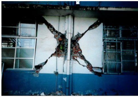
照片 6 翼牆與窗台
