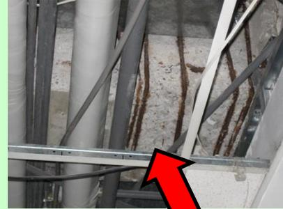
鋼筋產生鏽蝕，連帶也會降低構材的強度，並產生較大的變形。
