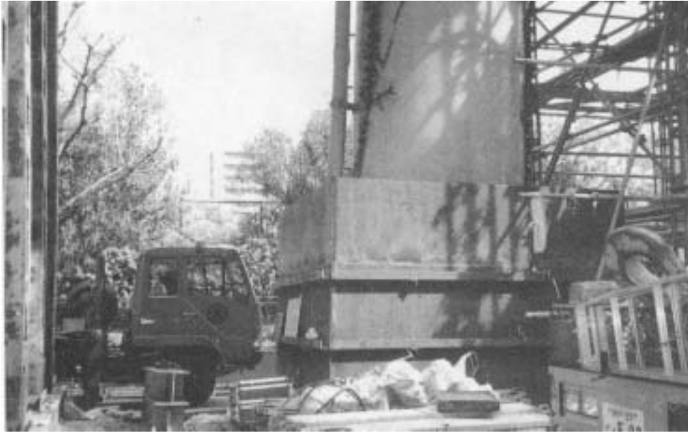
照片 7-6 RC 柱腳緊急補強
