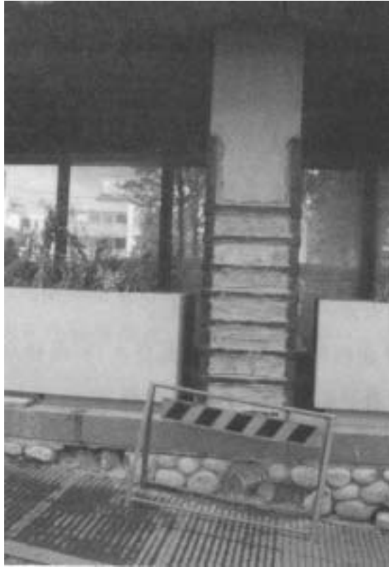
照片 7-8 外包角鋼及扁鋼補強
