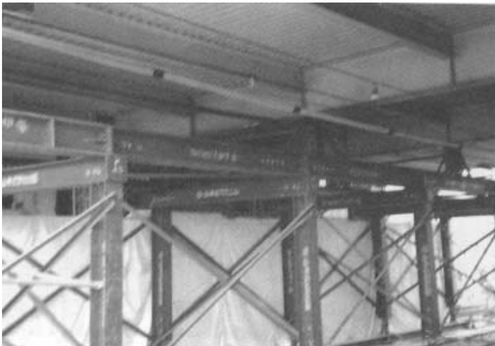
照片 7-3 以立體型支撐作緊急補強
