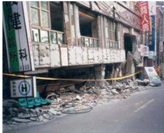
照片 5-4 外牆裝修材
