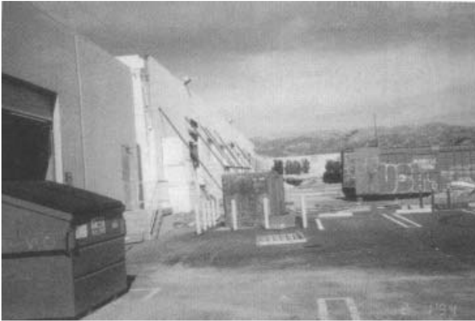
照片 7-4 以外部支撐作緊急補強
