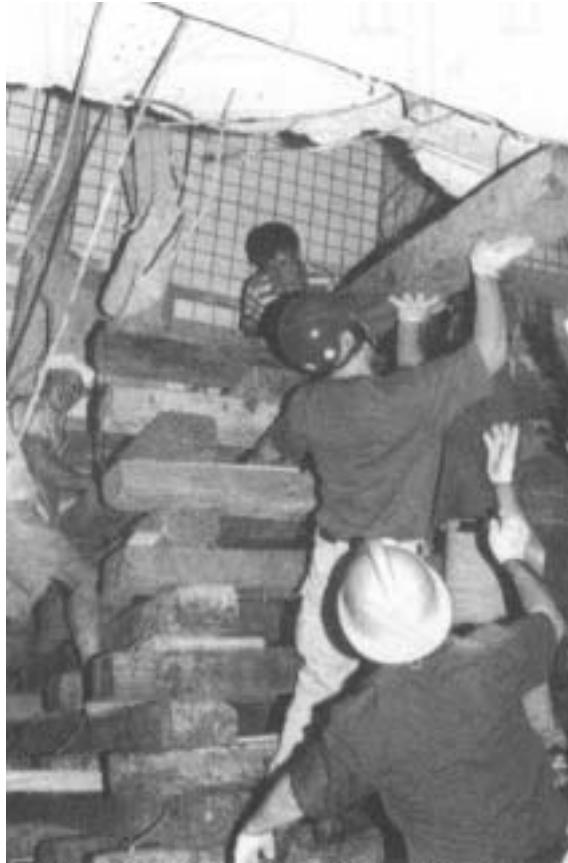
照片 7-2 正在搭建中的枕木框格架
