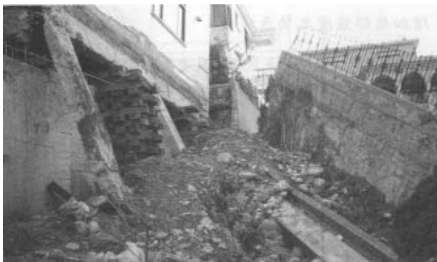
照片 7-1 以枕木框格架作緊急補強
