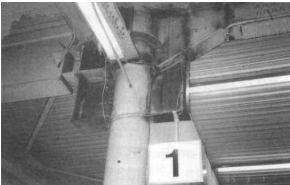
照片 7-7 鋼樑端部臨時托座
