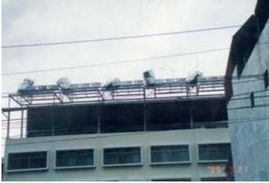
照片 5-7 屋頂水塔
