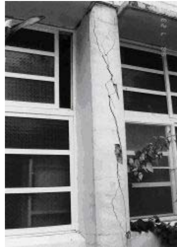
照片 4 柱明顯之剪力型裂縫，拌隨箍筋失效所產生之劈裂裂縫，破壞程度為 級。
